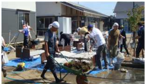
復旧作業には、一日200人以上が参加することもあった。
