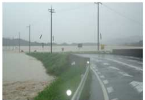
9月16日 朝、三愛荘から戸田地区へ向かう広域農道は完全に冠水。
